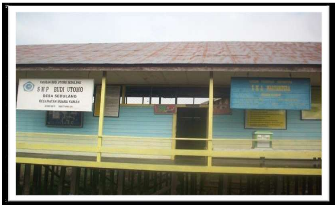
Gambar 12. Bangunan Sekolah Desa Sedulang Kecamatan Muara Kaman
