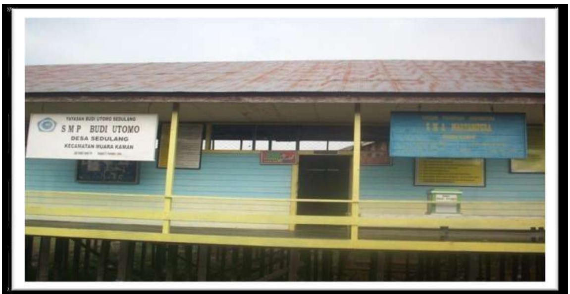
Gambar 12. Bangunan Sekolah Desa Sedulang Kecamatan Muara Kaman
